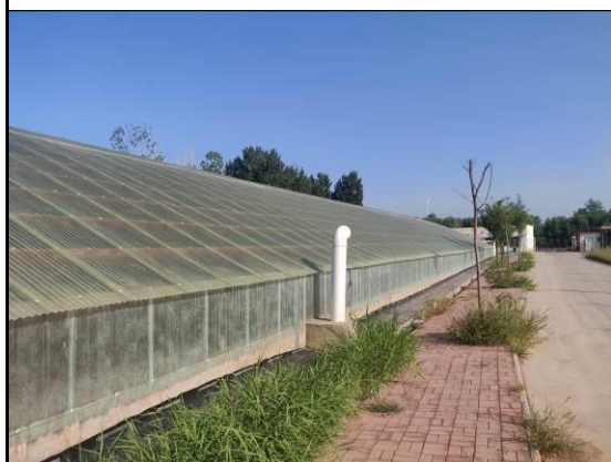
1C 污水处理区（调节池）
