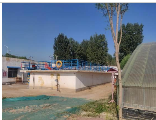
1C 污水处理区（反硝化池）
